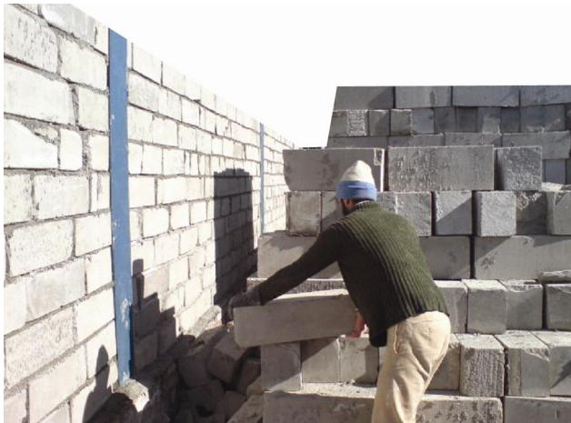
در بتن سبک CLC یکی از انواع بتن سبک بوده که به وسیله ایجاد حباب‌های هوا با اندازه‌های مختلف در درون بتن ایجاد می‌شود. روش تولید این نوع بتن یک روش بدون اتوکلاو است. ایجاد حباب هوا در این نوع بتن با یکی از دو روش مختلف فیزیکی یا استفاده از مواد افزودنی شیمیایی صورت می‌گیرد. به عنوان مثال، این محصول می‌تواند از ترکیب سیمان، ماسه بادی، آب و ماده شیمیایی تولید کننده کف تشکیل شود. این نوع بتن دارای مصارف مختلفی در صنعت ساختمان است مانند جداکننده‌های داخلی و خارجی ساختمان و ...
